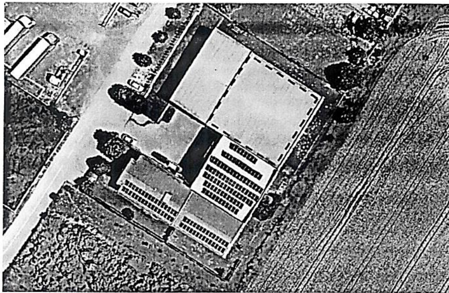
Слика 1. Позиција објекта на основу ГПС координата
